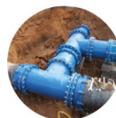
Redes de agua potable
